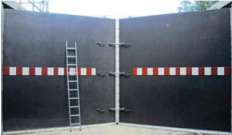
Abbildung 12: zweiflügliges Hochwasserschutztor (Hochwasserstemmtor)
